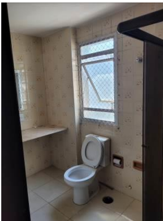
FOTOS N° 23/24: Vista parcial interna, do imóvel vistoriado.
