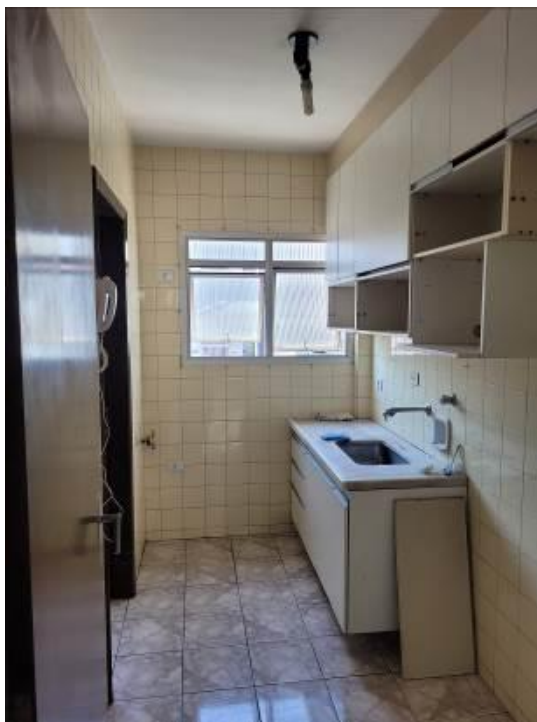
FOTOS N° 15/16: Vista parcial interna, do imóvel vistoriado.
