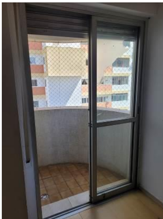
FOTOS N° 21/22: Vista parcial interna, do imóvel vistoriado.
