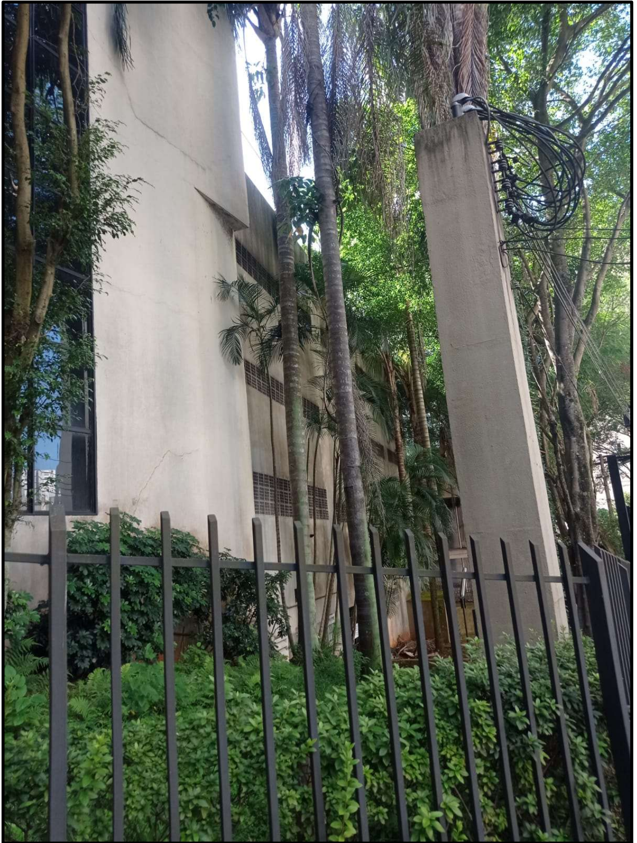
Garagem localizada nos 1° e 2° andares
