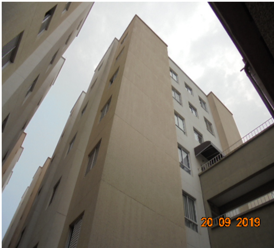
FOTO Nr.11: Detalhe externo da fachada do Bloco 05 – Prédio Toronto - e rampa de acesso a partir do estacionamento.
