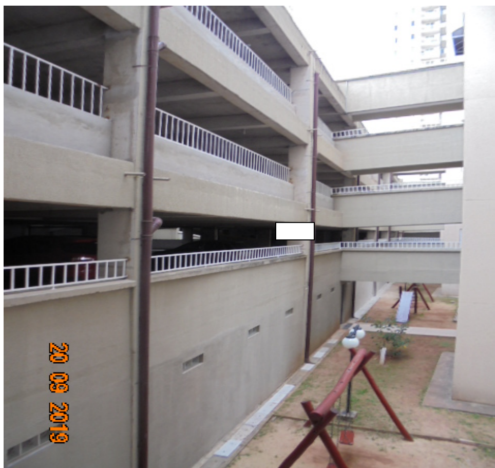
FOTO Nr.17: Vista geral do Bloco das vagas de estacionamento.
