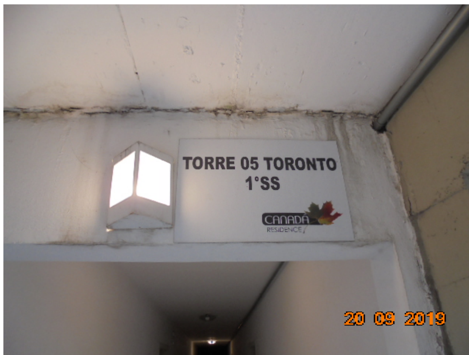
FOTO Nr.13: Identificação do Bloco do apartamento avaliando.
