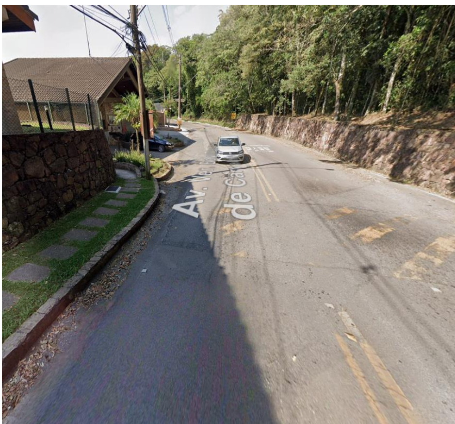
Foto 01: Vista do trecho da Avenida Vereador Belarmino Pereira de Carvalho
